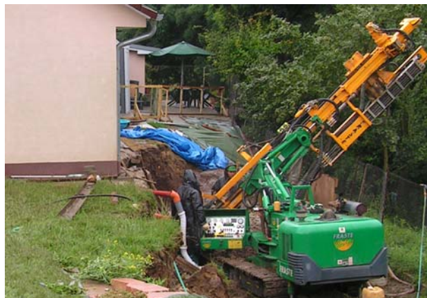
Obr. 5. Podchytenie základov rodinného domu so súpisným č. 712 mikropilótovou kotvenou stenou.
