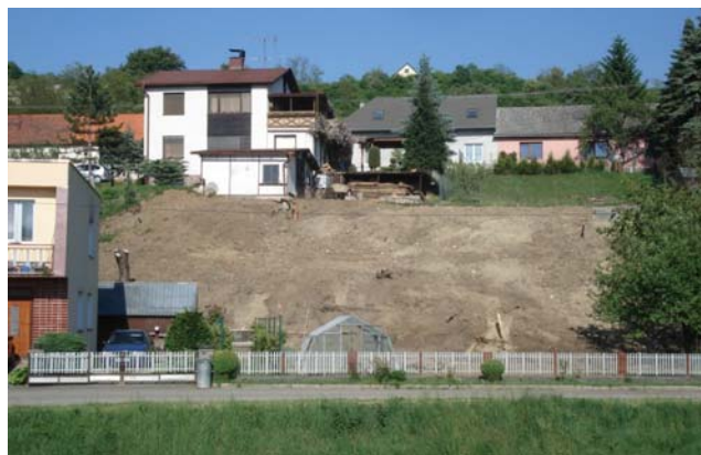
Obr. 12. Pohľad na svah po realizácii okamžitých sanačných opatrení (foto T. Bvoc).
