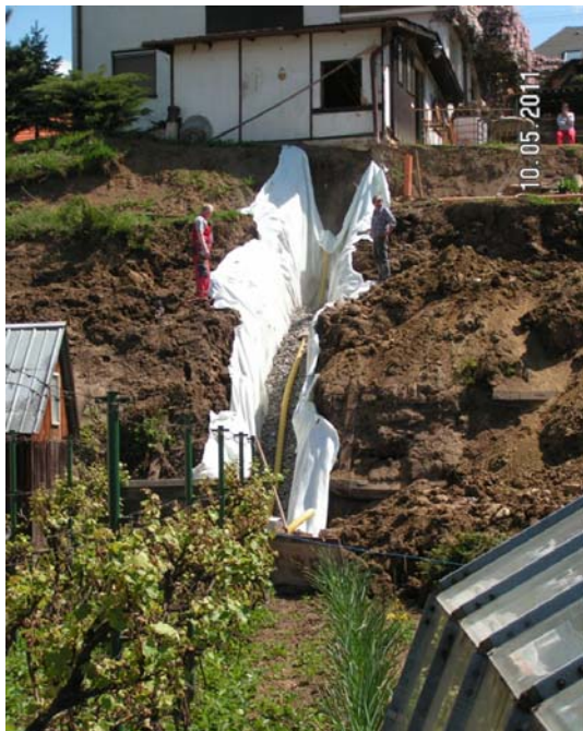
Obr. 11. Inštalácia drenážnej trubice typu „husí krk“ do kameninového lôžka v prieskumnej ryhe 1 (foto P. Liščák).
