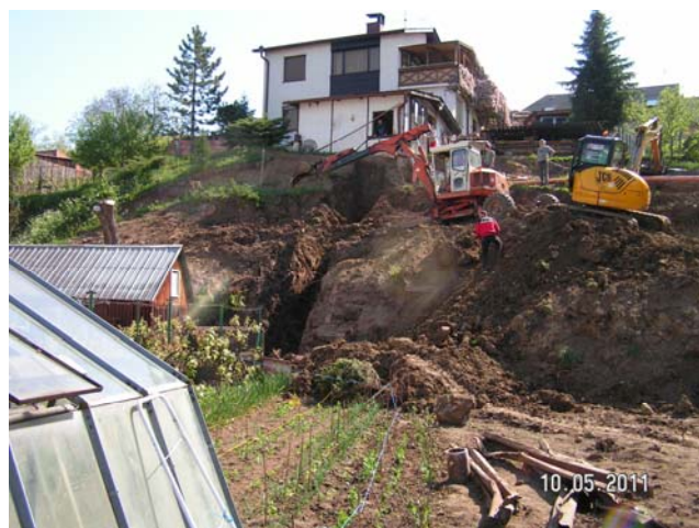
Obr. 10. Hĺbenie prieskumnej ryhy 1 (foto P. Liščák).
